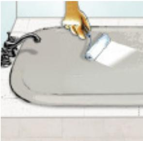
Terminar con 2 capas a intervalos de 24 horas, del ESMALTE TITANLUX ASPECTO CERAMICO de dos componentes.
